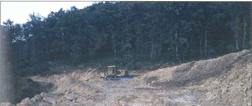
Aterrazamientos para repoblaciones en zonas de bosque autóctono
